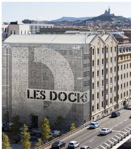
Marseilles Docks, Marseille/France (2009-2015)
